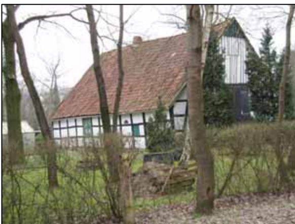
Abbildung 32: Heuerhaus, Ahauser Straße 53
