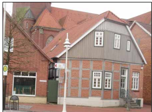
Abbildung 27:, Marktstraße 7, Lan- ge Straße 69 (von links)
