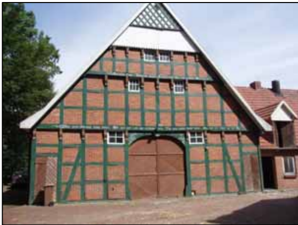
Abbildung 36: Wohnwirtschaftsgebäude, Barlager Straße 4
