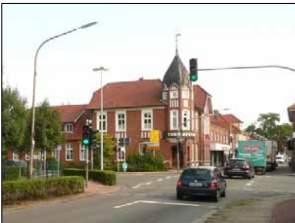
Abbildung 26: Wohn- u. Ge- schäftshaus, Lange Straße 52
