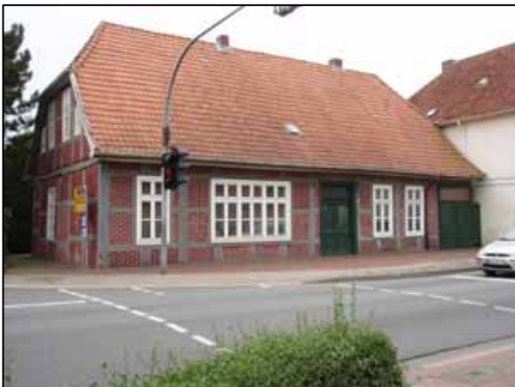
Abbildung 24: Wohn- u. Ge- schäftshaus, Lange Straße 53
