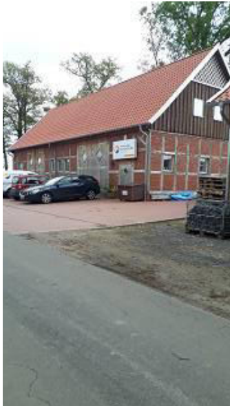
EP9. Kaiserhof 7 (Blick auf Metallbau von Standort)
