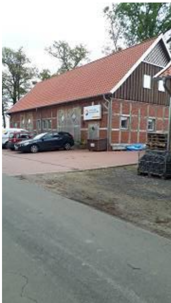
EP9. Kaiserhof 7 (Blick auf Metallbau von Standort)
