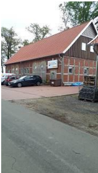
EP9. Kaiserhof 7 (Blick auf Metallbau von Standort)
